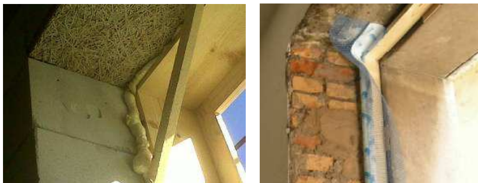
Figura 31.2 Schiumatura e nastratura dei falsi telai
