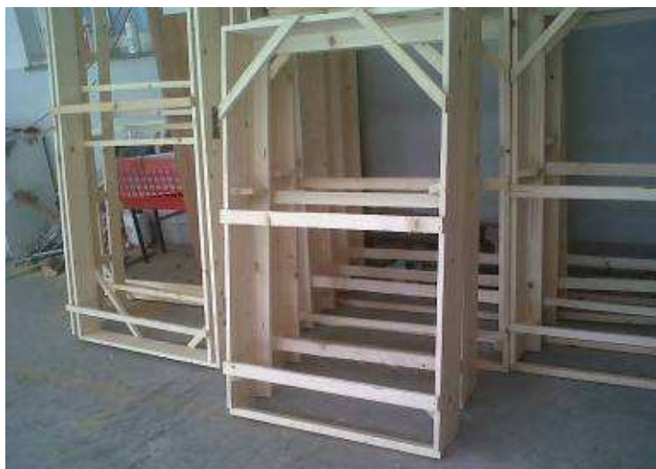
Figura 31.1 - Falsi telai in legno
